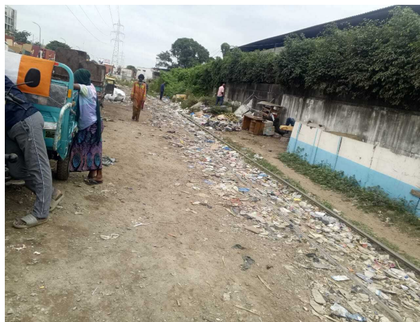
Photo 3. La voie ferroviaire envahie par les ordures dans le quartier de Vridi à Port-Bouët
