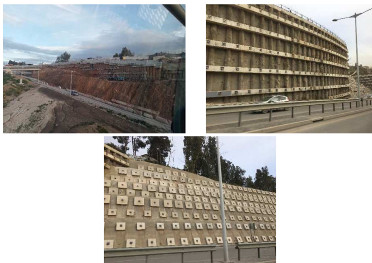
Figure 4. Aménagement des versants (Grecu, 2023 et 2026)
