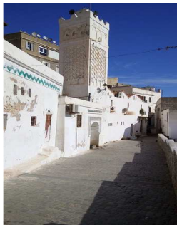
Fig. 2. La mosquée Sidi Ramadane (Source : Auteur, 2018)
