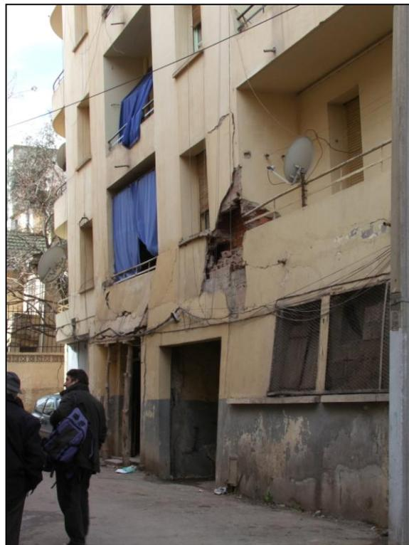
*Fig. 9.* La ville de Constantine. Des constructions affectées par des glissements de terrain (photo du janvier 2009)
